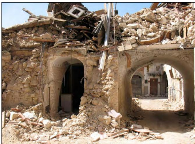
Figure 12 e 13. Ingresso di uno dei caratteristici cortiletti di Onna, con ingressi voltati a botte e arricchiti da arcate in pietra tipiche dell'architettura locale, prima e dopo il sisma del 2009
