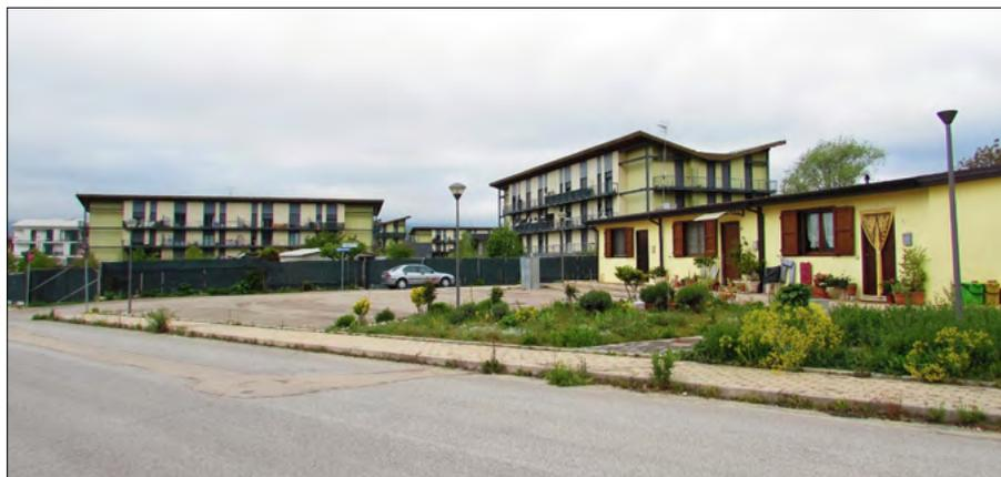
Figura 5. La fotografia mostra la convivenza all'interno della stessa area di alcuni edifici di un insediamento C.A.S.E. con le casette in legno del progetto M.A.P. È evidente la differente configurazione architettonica e spaziale (anche nelle dimensioni e nel numero di piani) delle due soluzioni abitative scelte per far fronte all'emergenza
