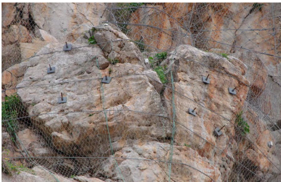
Figura 20. Pannelli di funi in acciaio zincato con diametro di 8 mm armati con funi di maggiore diametro (Cafiso, 2007)
